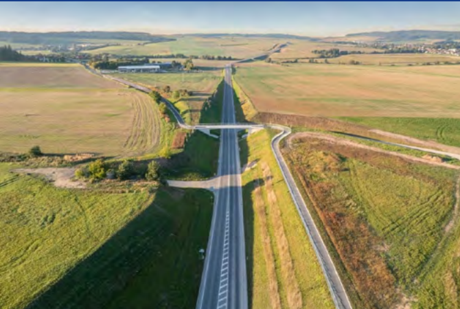
7. 10. 2025 bylo otevřeno nové napojení na dálnici D5. Podíleli jsme se na přípravě tohoto projektu a budeme se aktivně podílet na vyhledávací studii prodloužení silnice až po křižovatku Němčovice - Olešná.
